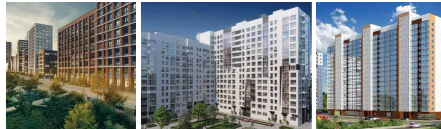
ЖК Домашний (СУ-10 ФУНДАМЕНТСТРОЙ)
